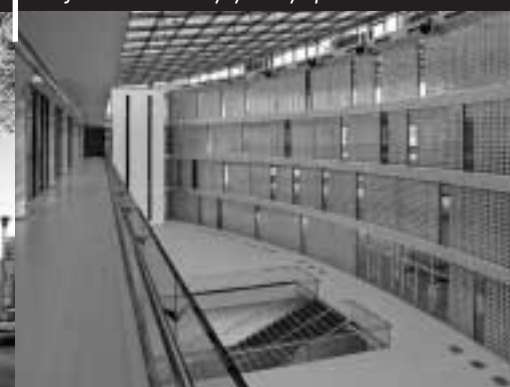
Sklo je v interiéru knihovny významným prvkem
