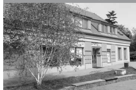
Infocentrum s knihovnou MČ Praha-Kolovraty (budova)
