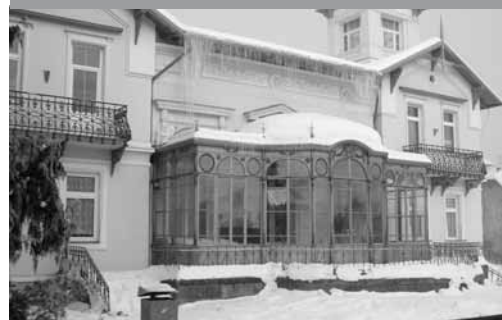
Budova kulturního domu s knihovnou
