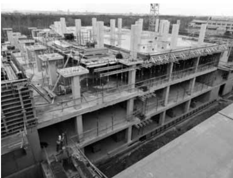
Výstavba nové budovy CDH
