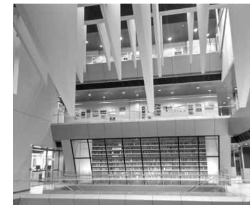
Světlovody vedou z koruny knihovny a zajišťují dostatek světla i v případě výpadku elektřiny
