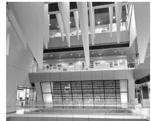
Světlovody vedou z koruny knihovny a zajišťují dostatek světla i v případě výpadku elektřiny
