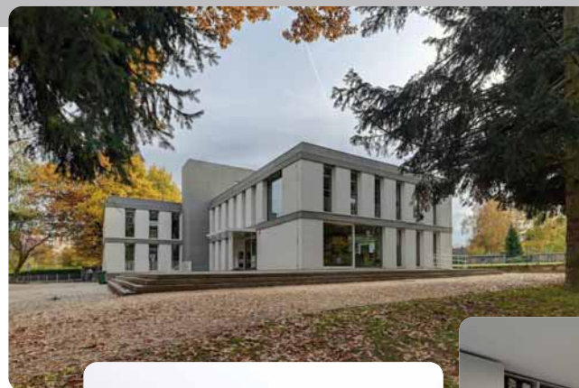
Městská knihovna Chodov v novém s. 36–37 ← Nová budova knihovny po rekonstrukci
