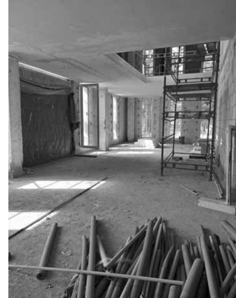
Rekonstrukce objektu byla skutečně důkladná
