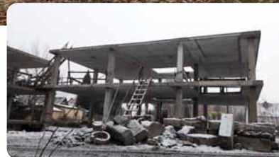
↑ Z původní budovy zůstaly pouze nosné prvky
