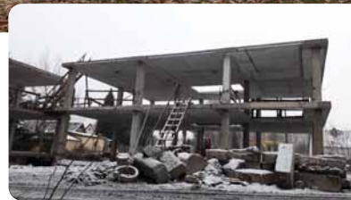
↑ Z původní budovy zůstaly pouze nosné prvky
