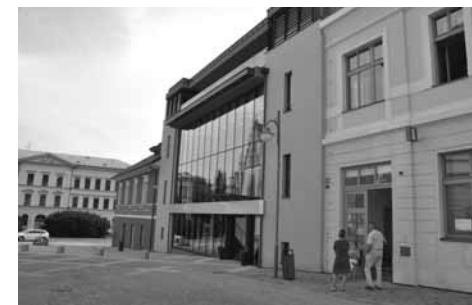
Pohled na budovu knihovny od severu; v čele je budova základní školy
