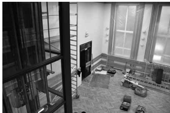
Nový prosklený výtah usnadňuje bezbariérový přístup do knihovny
