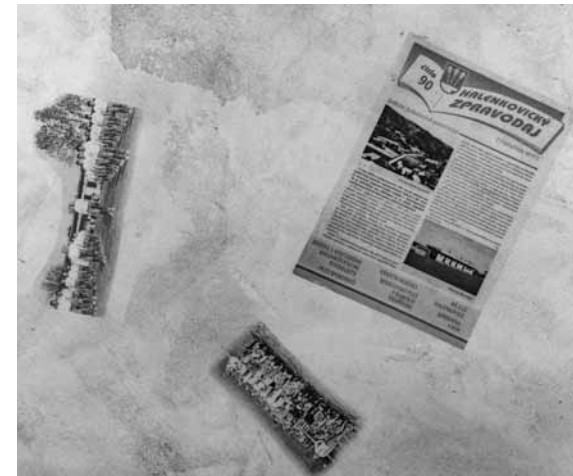
Stěrkována podlaha připomínající historii obce
