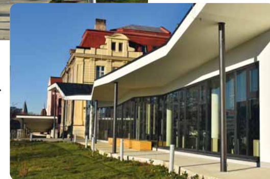
Depozitář SVKUL – exteriér →
