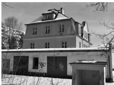
V rámci rekonstrukce byly odstraněny původní nevzhledné přístavby
