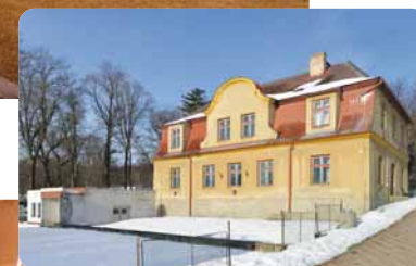
↑ Původní stav objektu Foto: J. Appeltauer
