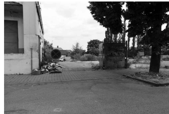
Pozemek v Divadelní ulici před začátkem stavby budovy depozitáře
