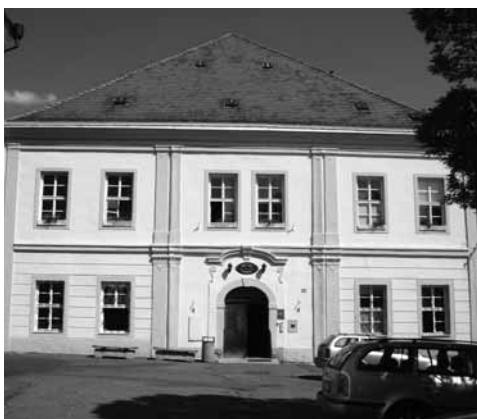
Knihovna sídlila v období 1994–2020 v budově bývalého církevního gymnázia
