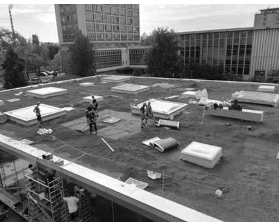
Momentka z doby výstavby: střešní světlíky a první vrstva podkladu pro „zelenou střechu“, která vytvoří příjemné klima
