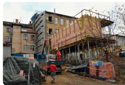
↑ Z průběhu rekonstrukce a přístavby knihovny na Slezkém náměstí
