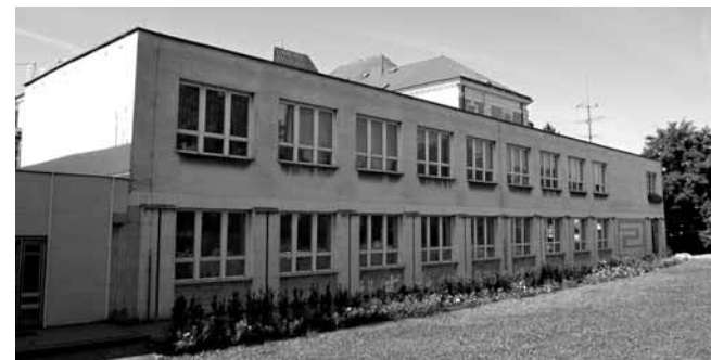
Budova knihovny v Ostravské ulici
