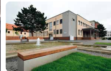
↑ Budova kulturního domu s knihovnou
