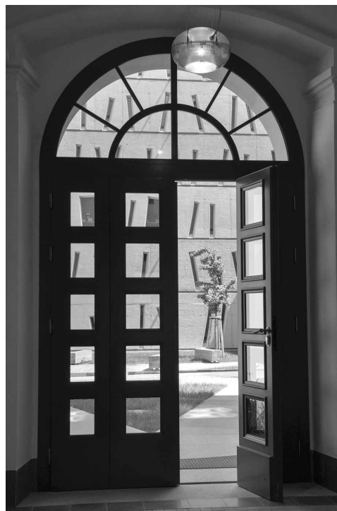
Průhled na přístavbu skladů
