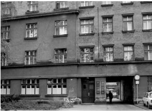
Sídlo Městské knihovny v Pardubicích v letech 1938–1960 (původně budova pohřebního ústavu, dnes zdravotní středisko)
