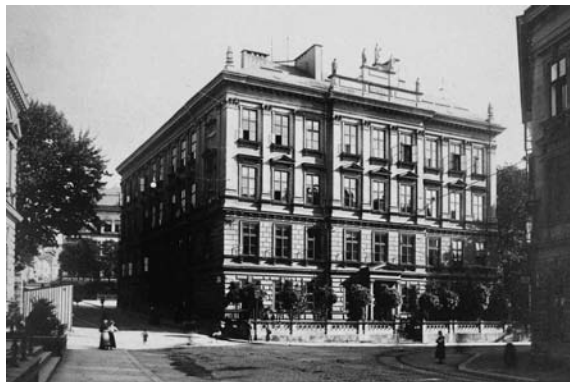
Budova dívčí měšťanské školy v Jablonci n. Nisou, v jejímž východním křídle měla v letech 1923 až 1933 prostory německá městská knihovna; v roce 1926 k ní byla ještě připojena německá veřejná čítárna
