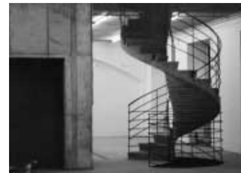
Duben 2003 – stavba schodiště
