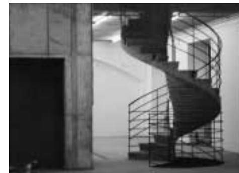
Duben 2003 – stavba schodiště
