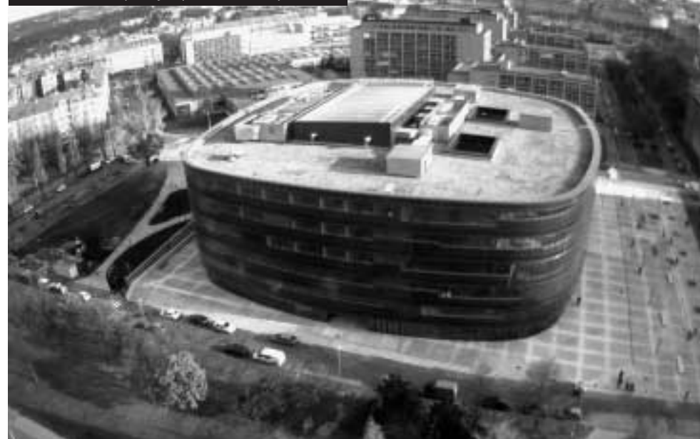
Foto z webové kamery sledující výstavbu NTK – listopad 2008
