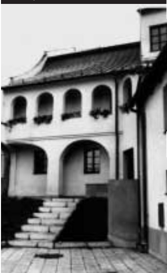
Arkáda po rekonstrukci
