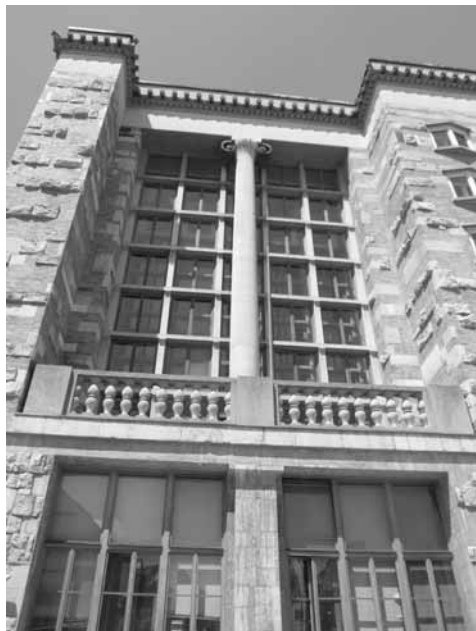
Vysoká okna vedou do velké studovny NUK Ljubljana
