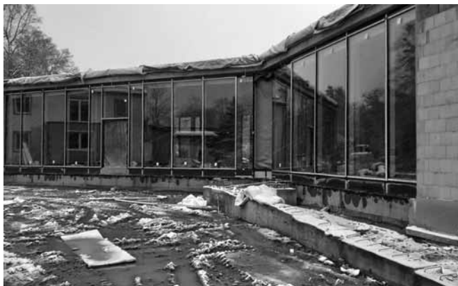
Pohled ze zadu na již hotovou a zasklenou přístavbu
