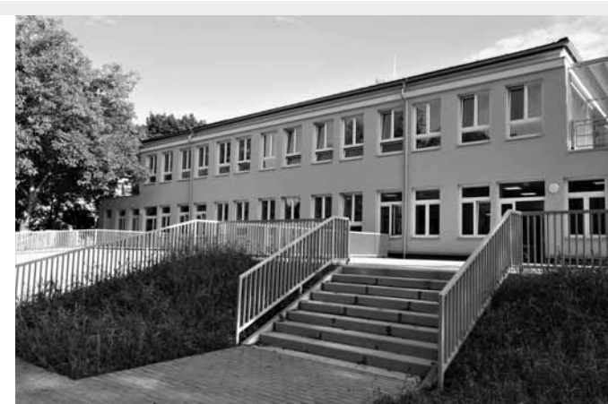
Nová terasa je větší, světlejší, a hlavně bezpečná
