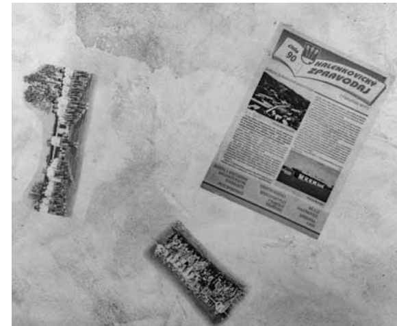
Stěrková podlaha připomínající historii obce
