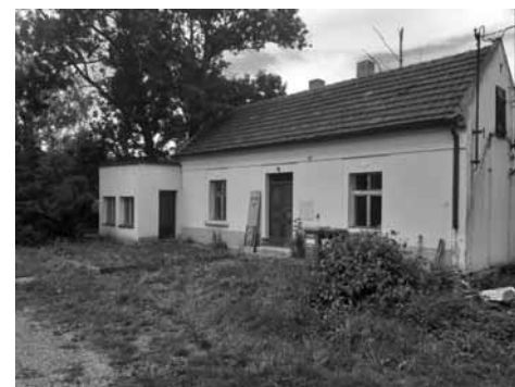
Původní stav objektu...
