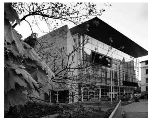
Moderní budova KVK Liberec; objekt vlevo: nová židovská modlitebna
