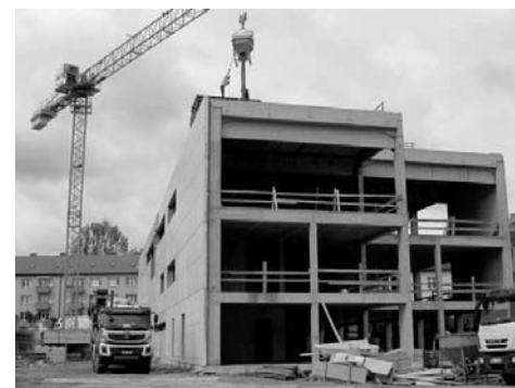
Pohled na stavbu knihovny od řeky Sázavy
