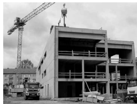
Pohled na stavbu knihovny od řeky Sázavy
