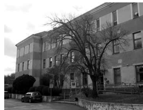
Budova bývalých kasáren sloužící dnes jako knihovna se dočká kompletní rekonstrukce
