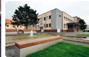
↑ Budova kulturního domu s knihovnou
