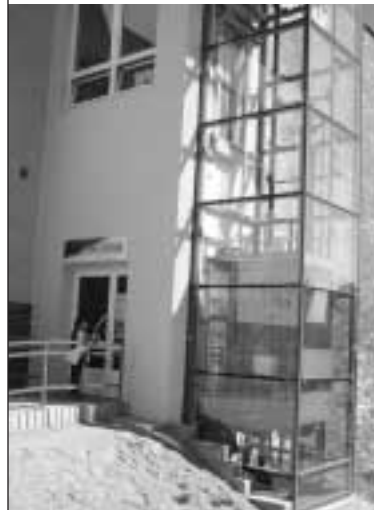
Bezbariérový přístup do Obvodní knihovny Plzeň-Lochtín s dominantou proskleného bezbariérového výtahu
