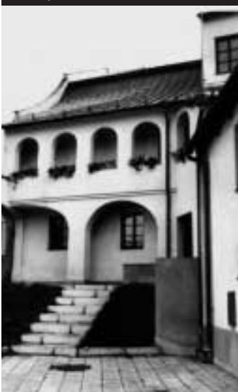
Arkáda po rekonstrukci
