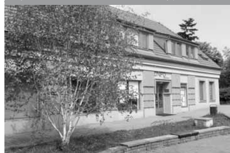
Infocentrum s knihovnou MČ Praha-Kolovraty (budova)
