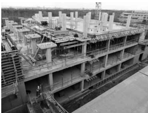
Výstavba nové budovy CDH
