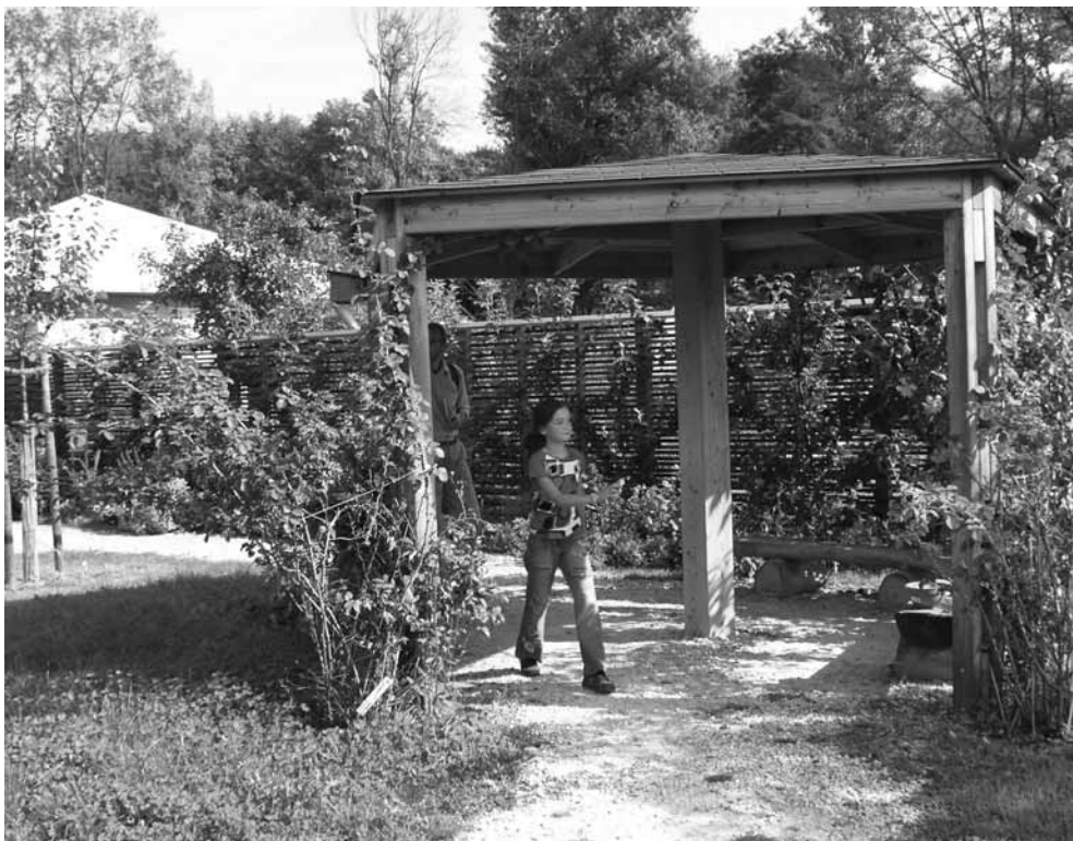
Přístřešek v komunitní zahradě
