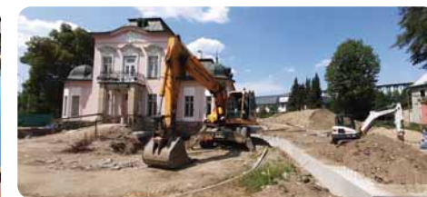
↑ Zhutňování terénu pod základovou deskou přístavby ← Přístavba – pohled od hlavního vchodu do čítárny časopisů, vlevo pult samoobslužné kavárny, PC s veřejným internetem, dveřmi možný výstup na zahradu
