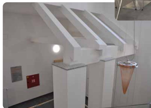
↓ Schodiště s designovým osvětlením
