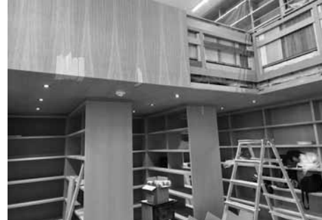
Momentka z období probíhající rekonstrukce
