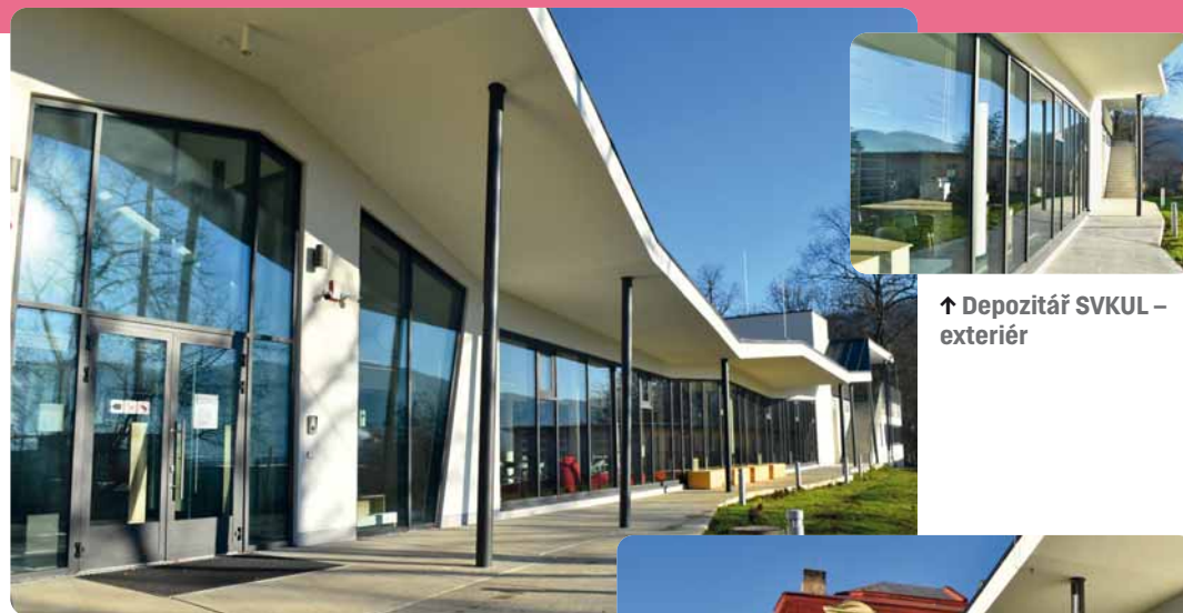
Nový depozitář SVK v Ústí nad Labem s. 228–229 ↑ Hlavní vchod do depozitáře
