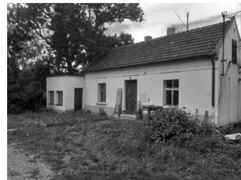
Původní stav objektu...
