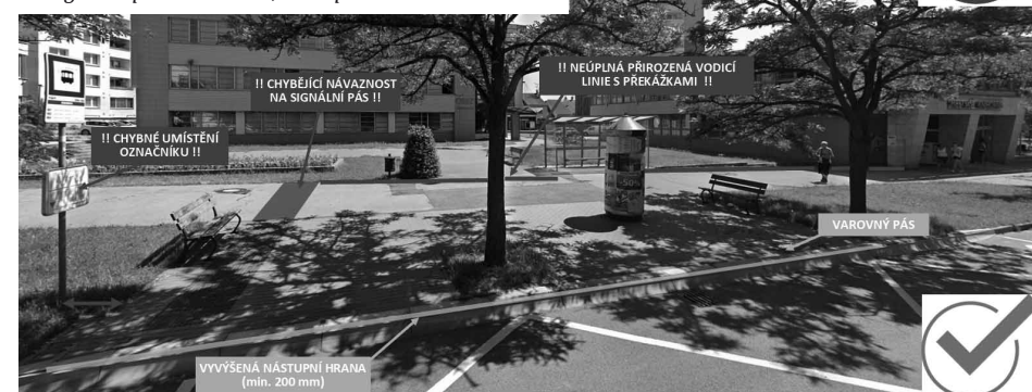
Obr. 4 – Příklad řešení návaznosti zastávky MHD na budovu knihovny v Hodoníně, kde se setkáváme s chybným umístěním označnicku, nenapojením přirozené vodicí linie na signální pás a umístění, nebo přerušení vodicí linie
