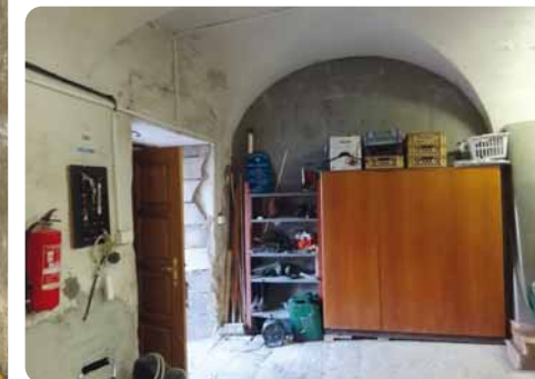
↑ Budoucí prostory knihovny před jejich rekonstrukcí (pracoviště údržby města, cca 2016) Foto: stavební dozor
