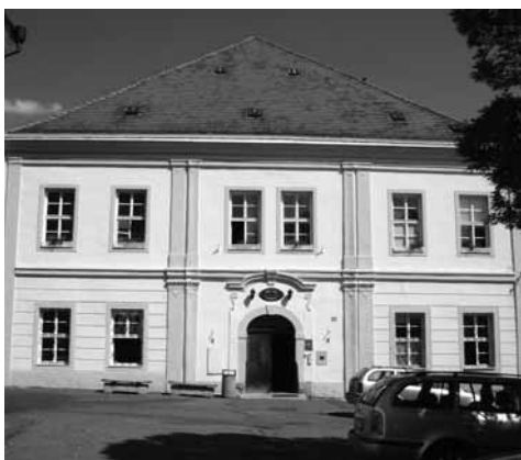
Knihovna sídlila v období 1994–2020 v budově bývalého církevního gymnázia
