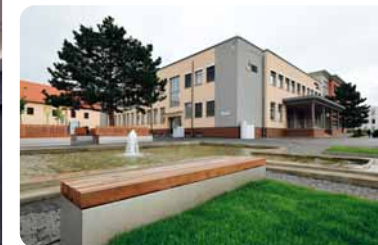
↑ Budova kulturního domu s knihovnou
