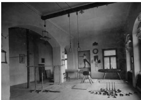
Tělocvična v budově dnešní Městské knihovny Přelouč, která byla zadaptována na čítárnu a pozdější vestavba v horní části místnosti dnes slouží jako sklad knih
