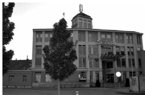
Fabrika – zajímavá přestavba tovární budovy, ve které sídlí Městská knihovna ve Svitavách
