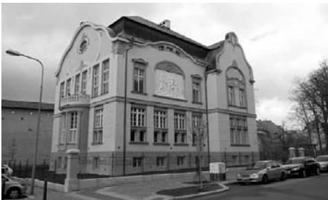
Budova MěK v Chebu po rekonstrukci z let 2012–2014
