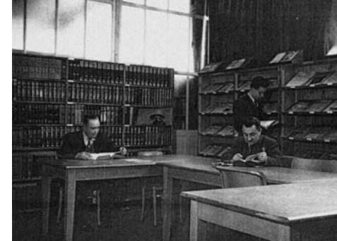
Z interiéru národohospodářské knihovny Studijního ústavu ve Zlíně
