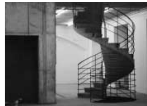
Duben 2003 – stavba schodiště
