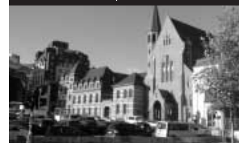
Budova na Rue Van Maerlant, 18
